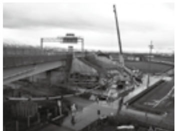
付加車線設置事業工事 (橋梁下部工事)の様子 ▶P.23
