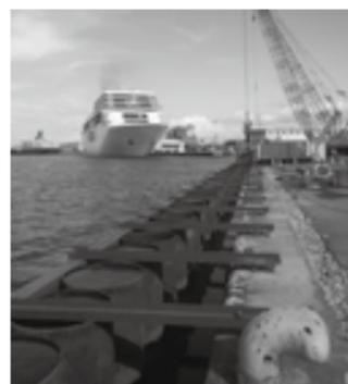
岸壁前面 鋼管矢板の打設
