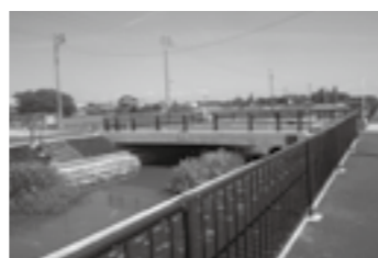
H形鋼を用いた門形ラーメン橋完成(下流→上流)▶P.17
