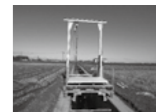
CSクレーン設置状況▶P.27
