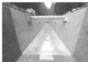
靱性モルタルNA塗布▶P.11
