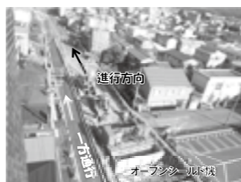
オープンシールド工法の施工状況▶P.7
