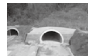
西松建設(株) 金沢東環御所トンネル(2期線)工事(2017年竣工)▶P.23
