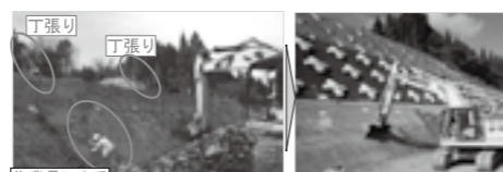
作業員による 仕上り確認 [切土法面整形の施工] (左)従来の法面整形 (右)ICT油圧ショベルによる法面整形▶P.53
