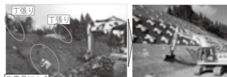
作業員による 仕上り確認 [切土法面整形の施工] (左)従来の法面整形 (右)ICT油圧ショベルによる法面整形 ▶ P.53
