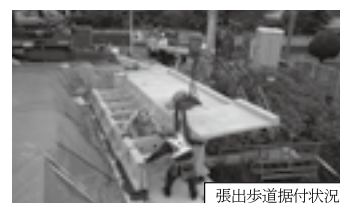
張出歩道据付状況
