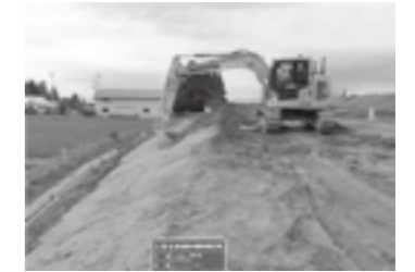
ICT建機による法面整形 ▶P.13
