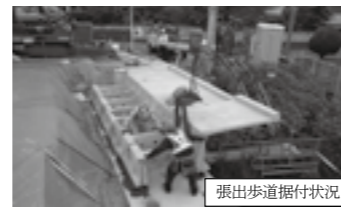
張出歩道据付状況
