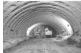
上荒川地区トンネル工事 (上：坑口 下：坑内) ▶P.9
