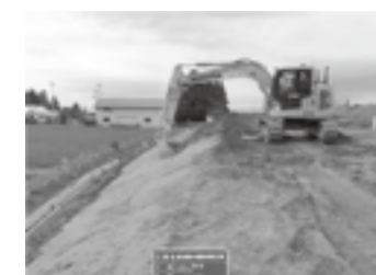
ICT建機による法面整形 ▶P.13
