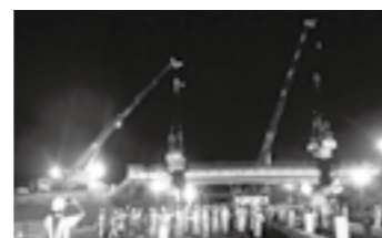
跨高速道路橋の撤去状況 ▶P.5
