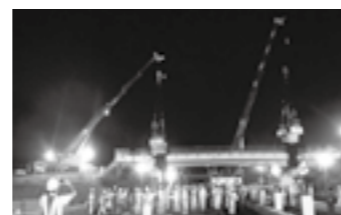
跨高速道路橋の撤去状況 ▶P.5
