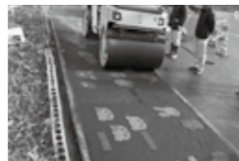
母体とイラストの同時 転圧状況▶P.41
