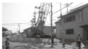
クローラークレーン設置▶P.15
