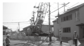
クローラークレーン設置▶P.15
