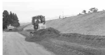
ICTブルドーザによる段切り状況▶P.9
