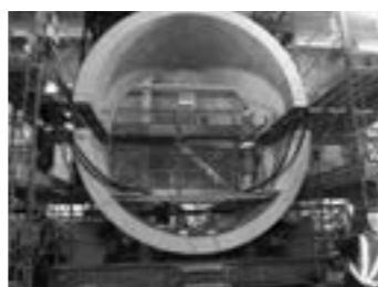
超大口径推進管上下部材接合状況 ▶P.11
