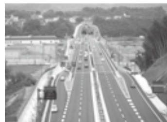
山側環状整備状況（大桑高架橋） ▶P.5
