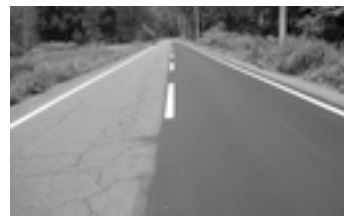
施工後の路面 （右：ヒートドレッシング）▶P.11
