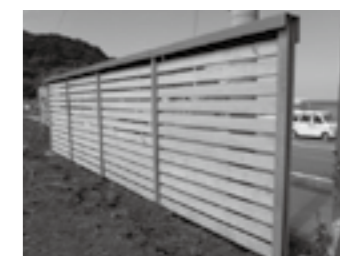
コンクリート防風板柵▶P.19
