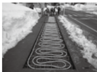
放熱管敷設状況▶P.7
