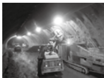
急速ずり処理システム (一次ずり出し) 作業状況▶P.9
