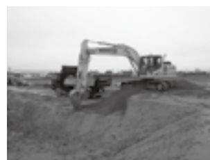
ICT建機（バックホウ）を 採用した施工▶P.5
