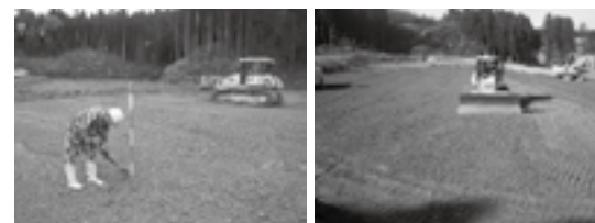
従来施工 ICT施工 ICT建機による施工 盛土工の作業状況▶P.9
