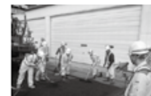
アスファルト舗装講習 (舗設体験)▶P.19
