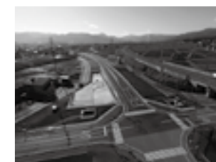
国道17号六日町バイパス (南魚沼市小栗山地区)▶P.24
