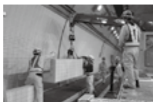
プレキャストL型擁壁設置工法 ▶P.13
