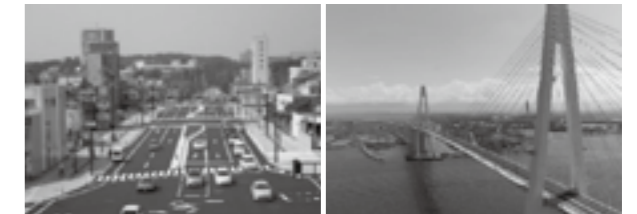
国道7号 (新潟市) 新湊大橋 (富山県) ▶P.63
