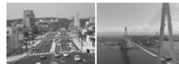
国道7号 (新潟市) 新湊大橋 (富山県) ▶P.63
