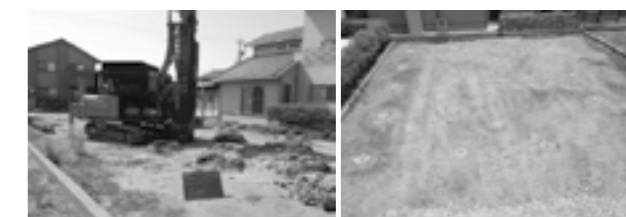
スクリュー・プレス工法-砕石パイラー▶P.17
