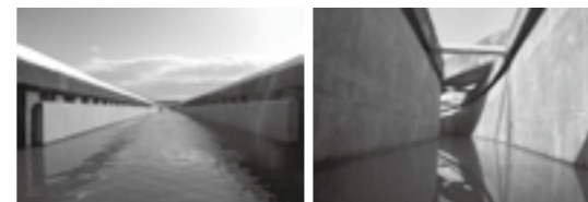
大断面の水路 狭隘で曲線的な水路 ストパネ工法による補修事例 ▶P.11
