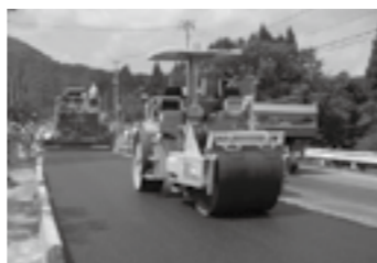
施工状況▶P. 9
