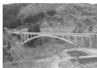
湯出島橋全景▶P. 5
