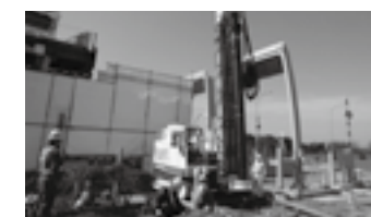
EAZET工法施工状況▶P.45
