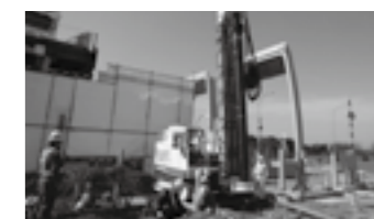
EAZET工法施工状況▶P.45
