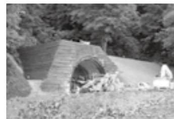
補強土による押え盛土(斜方向)▶P.13
