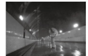
関越トンネル水噴霧設備点検の様子 ▶P.23
