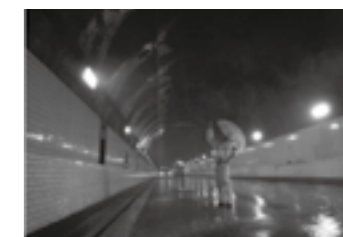
関越トンネル水噴霧設備点検の様子 ▶P.23
