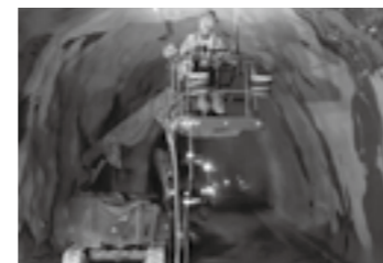
クローラー式高所作業車使用状況写真 ▶P. 7
