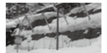
スロープガードネット工法 ポケット内の堆雪状況▶P.27
