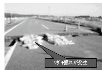
土のう積工(中越地震時の写真引用) ▶P.13
