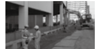
現場で打合せをしている様子▶P.23
