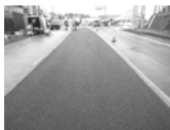
施工直後路面状況▶P. 9
