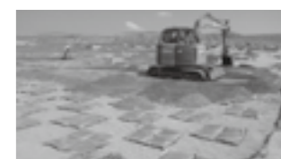
施工状況/現地砂埋戻し▶P.23
