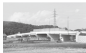
古栄跨線橋 ▶ P. 5
