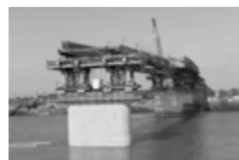
送り出し架設作業状況 ▶ P. 7
