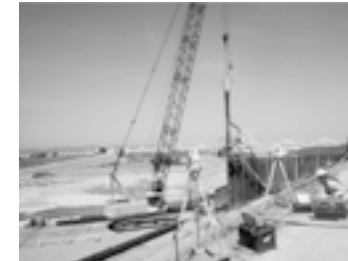
杭打設管理システム▶P. 9
