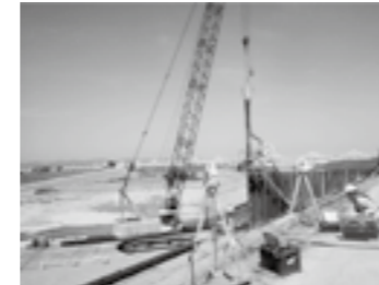
杭打設管理システム▶P. 9
