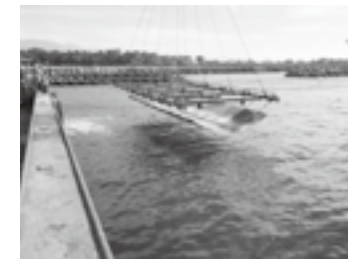
アスファルトマット海上運搬設置 ▶P.17
