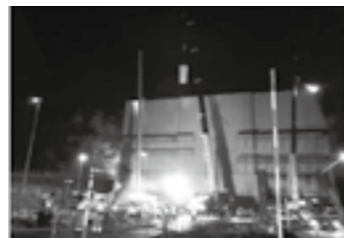
5階部撤去状況▶ P.45
