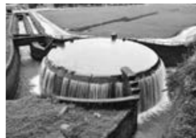
■東山円筒分水槽 (ヒガシヤマエントウブンスイソウ)
