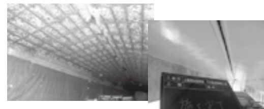
張出床版下面補修写真▶ P.11
