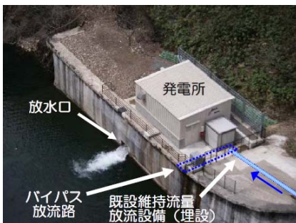
▲ 発電所設置後の現況
