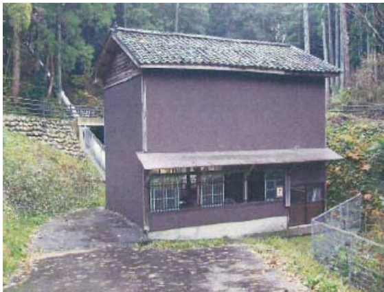
▲発電所建屋の状況
