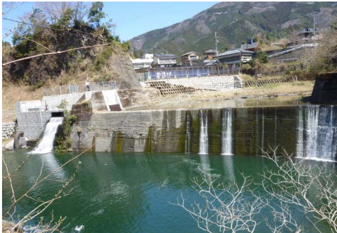
▲ 落差工及び発電施設の全体状況
