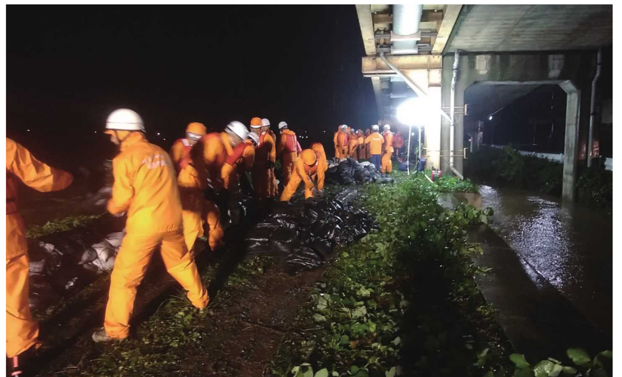
東京都日野市消防団 土のう積み工を実施(令和元年10月12日~13日:浅川右岸)
