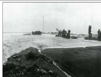
堤防決壊の様子 (入善町福島地内)
