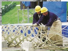
竹蛇籠による水防活動(写真上・昭和33年)と、竹蛇籠保存会による実演の様子(写真下)
