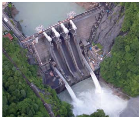
排砂中の出し平ダム(H26)
