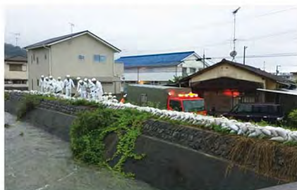
愛媛県西条市消防団 積み土のう工を実施 (平成30年7月6日：中山川水系大谷川)
