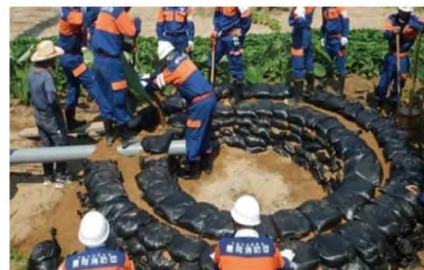
兵庫県豊岡市消防団 釜段工を実施 (平成30年7月15日：円山川左岸)
