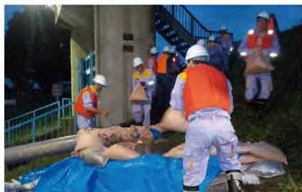
岐阜県岐阜市日置江水防団 月の輪工を実施 (平成30年7月8日：長良川左岸)
