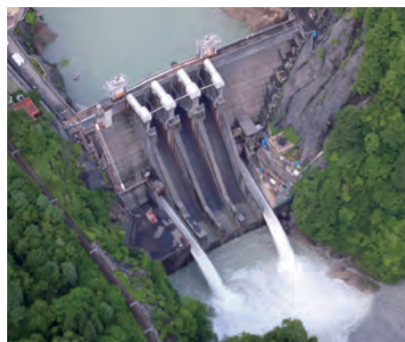
排砂中の出し平ダム(H26)
