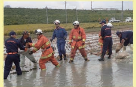
京都府久御山町消防団 釜段工を実施 (10月23日台風第21号:木津川右岸)
