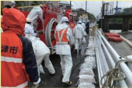
静岡県焼津市消防団 積み土のう工を実施 (6月21日梅雨前線豪雨:小石川左岸)
