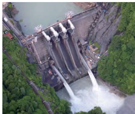
排砂中の出し平ダム(H26)
