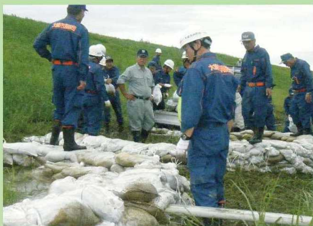
大崎市消防団による月の輪工法実施の様子
