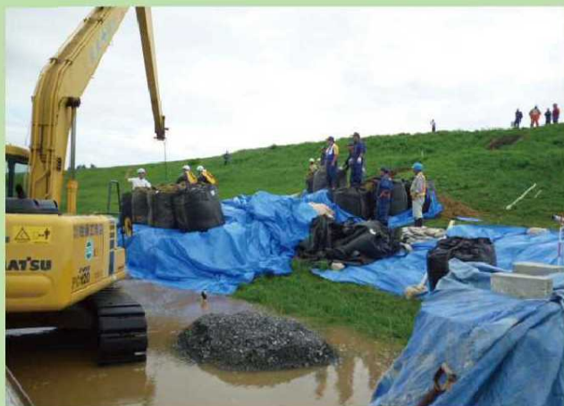
大型土のうを使用した月の輪工法実施の様子
