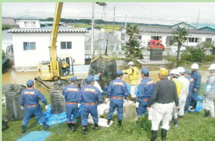
大型土のうを使用した月の輪工法実施の様子
