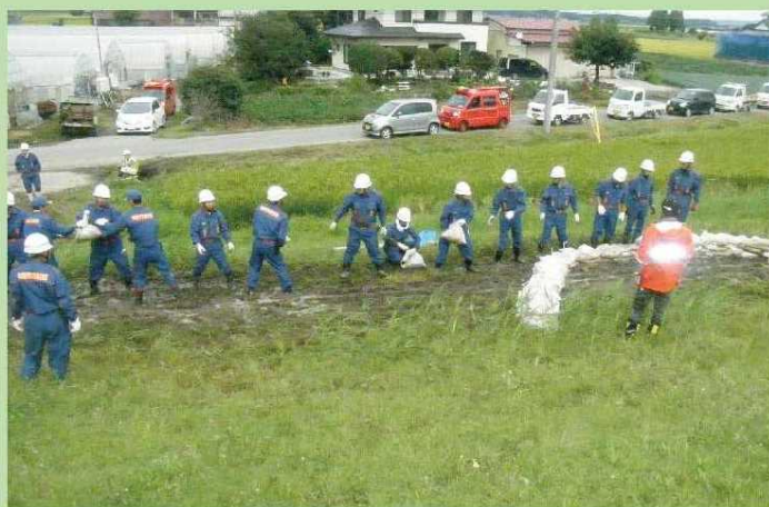
大崎市消防団による月の輪工法実施の様子
