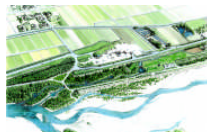
やすらぎ水路の整備
