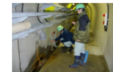
ダム堤体・放流設備の点検
