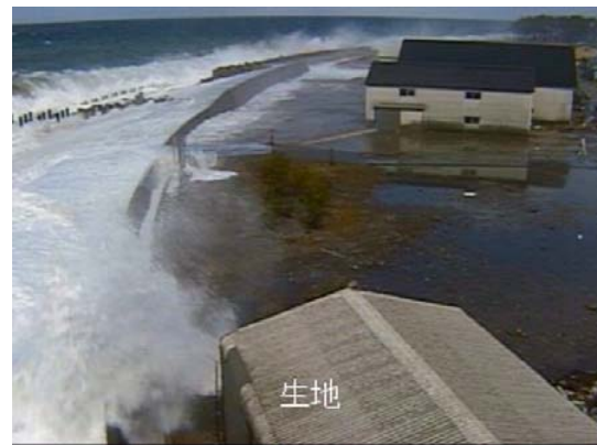
平成20年2月24日 冬季風浪による越波 状況(黒部市生地)
