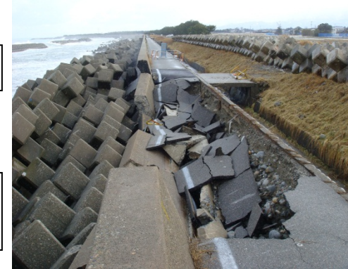
直立堤倒壊状況(H20.2.25)
