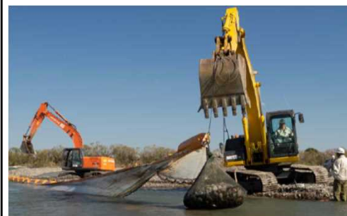
掘削前の防護膜の設置
