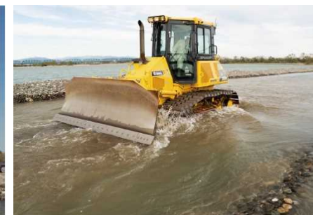
礫投入、礫の汚れ剥ぎ
