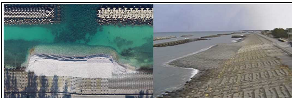
試験養浜の状況(令和2年12月時点)
