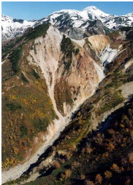
写真 2-2 祖母谷崩壊地
