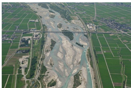
写真 2-19 複列砂州河道のレキ河原と瀬淵
