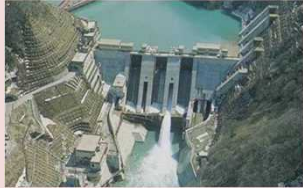
宇奈月ダム(H12完成) 国土交通省管理ダム
