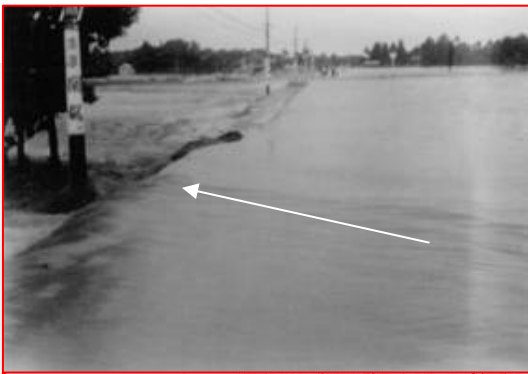
破堤により国道8号を越える濁流
