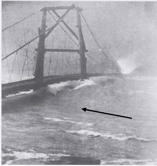
洪水流により流失直前の権蔵橋の状況
