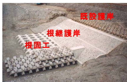
根継護岸工の整備
