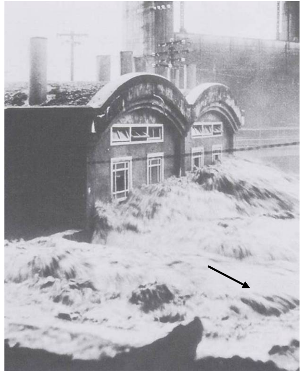
旧愛本堰堤管理棟よりふき出す洪水流の状況
