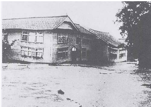
氾濫流による校舎倒壊状況(黒部市村椿地区)
