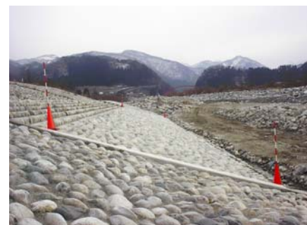
写真 5-10 護岸の補修
