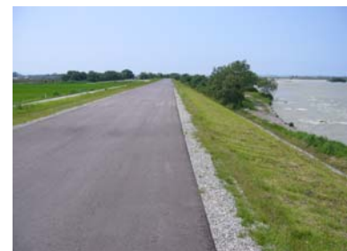
写真 5-9 堤防天端の舗装
