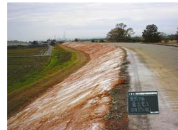
写真 5-7 堤防の補修
