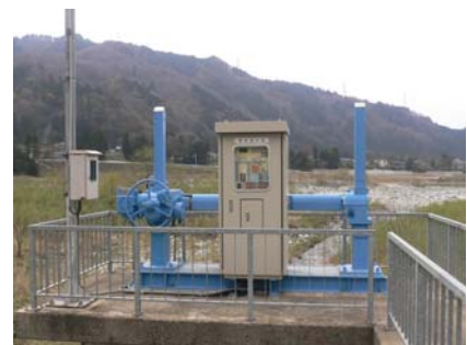
写真 5-11 河川管理施設の点検(樋管)
