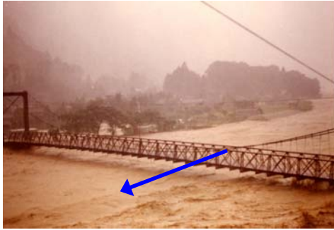
昭和44年8月洪水時の音沢地区 における流況
