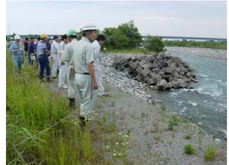
写真 5-4 関係機関による河川の巡視点検（重要水防箇所）
