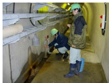
写真 5-14 ダム堤体・放流設備の点検
