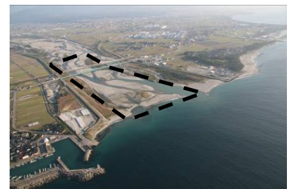
写真 3-15 河口の土砂堆積状況
