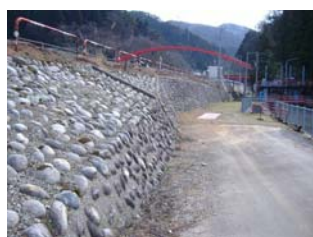
写真 3-11 左岸 13.2k の堤防
