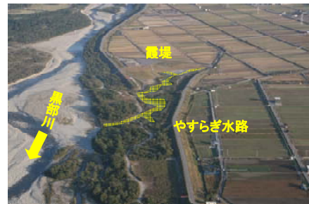
写真 3-4 霞堤を利用したやすらぎ水路（浦山）
