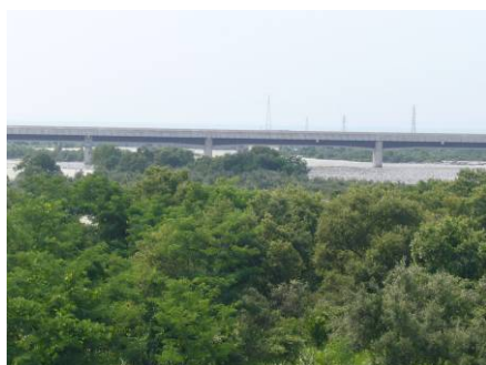
写真 3-16 高水敷に繁茂した樹木群
