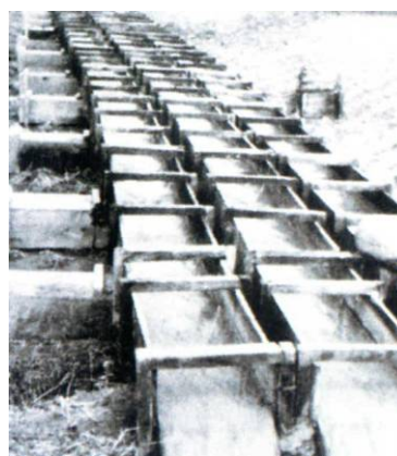
写真 2-5 流水客土の様子
