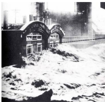
昭和27年7月洪水 愛本堰堤管理棟より吹き出す流水
