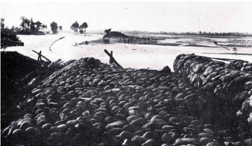
昭和9年7月洪水 五郎八の堤防の決壊状況 (減水後)
