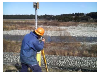
写真 5-5 定期横断測量
