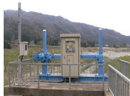
写真 5-11 河川管理施設の点検(樋管)
