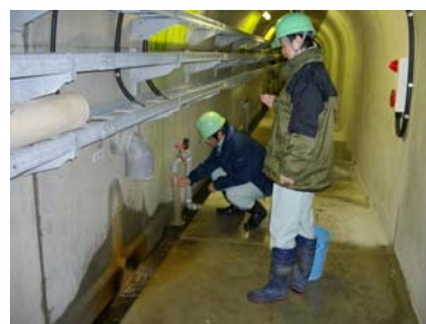
写真 5-14 ダム堤体・放流設備の点検
