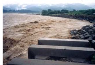
写真 5-6 洪水後の状況把握 (平成 10 年 7 月洪水)
