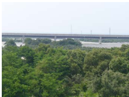
写真 3-16 高水敷に繁茂した樹木群
