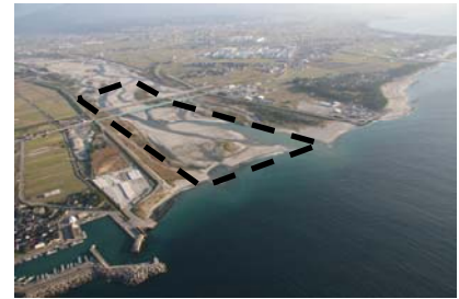
写真 3-15 河口の土砂堆積状況
