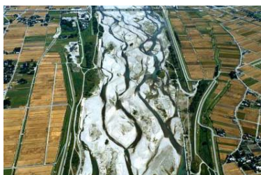
古くからの急流河川工法
