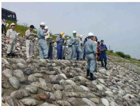
写真 3-22 関係機関による巡視・点検
