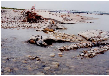
平成7年7月洪水 JR北陸線鉄橋上流左岸の護岸被災状況
