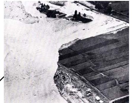
昭和44年8月洪水 福島の堤防決壊状況 (出水中)
