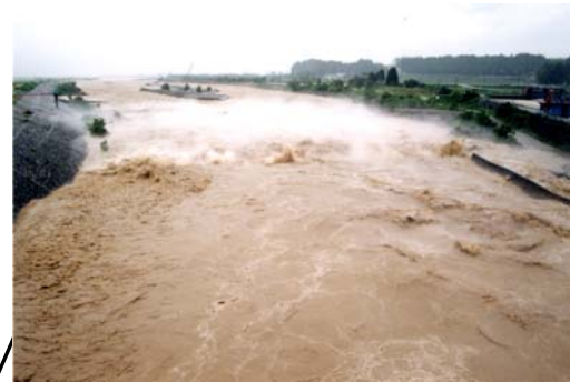
平成8年6月洪水 愛本堰堤下流の流況
