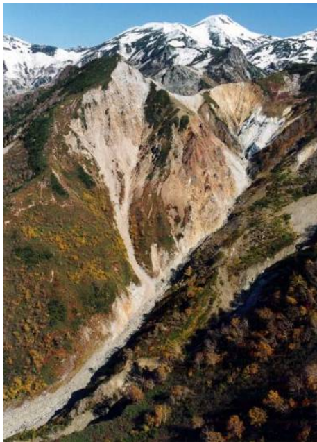
写真 2-2 祖母谷崩壊地
