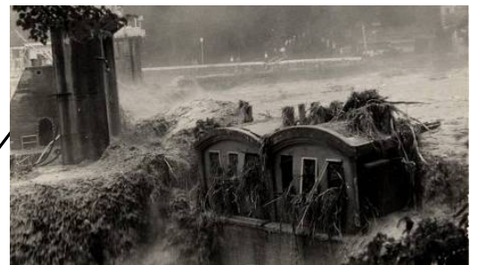
昭和44年8月洪水 愛本堰堤における流況
