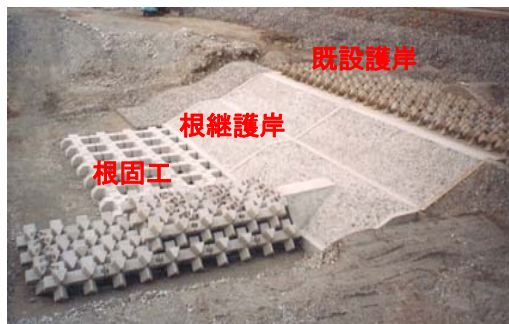
根継護岸工の整備
