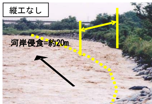
写真1 侵食による被災状況
