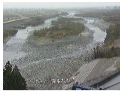
CCTVによるリアルタイム画像 (愛本右岸)
