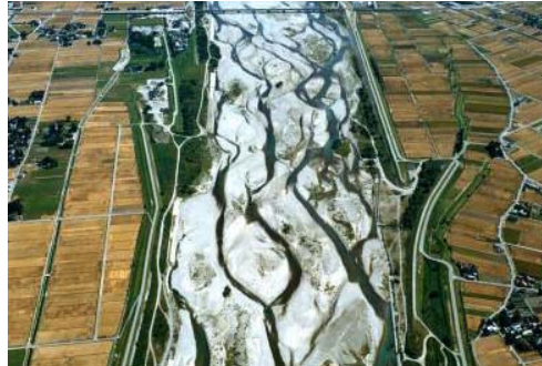
古くからの急流河川工法
