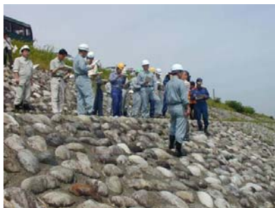
関係機関による巡視・点検
