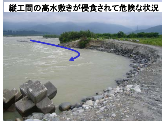
根固工が洗掘を受け危険な状況
