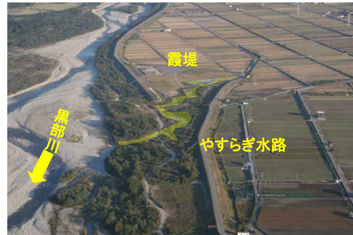
霞堤を利用したやすらぎ水路(浦山)
