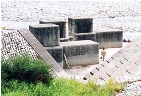
巨大な流水エネルギーに 対抗するための河川工法
