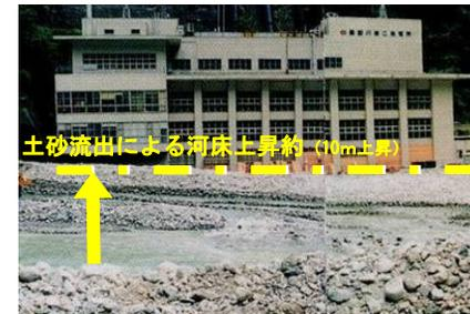
土砂流出による河床上昇約10m（前線）
