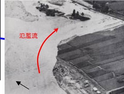
洪水流による破堤状況（福島地先）
